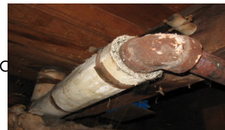
Asbestos pipe lagging
